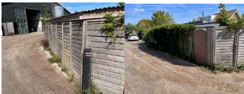
Figuur 13: Schutting tussen bedrijf en verhuurde eigen woning
