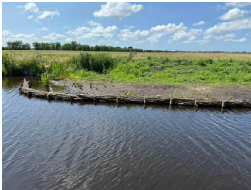
Afbeelding 3.9 Voorbeeld van een beschoeiing van wilgentenen
