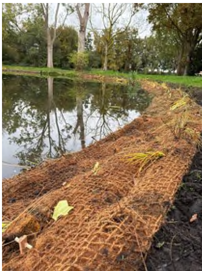
Afbeelding 3.6 Voorbeeld kokosmatten oeverbescherming links na aanleg (bron: TEFAB) en rechts na begroeiing met helofyten
