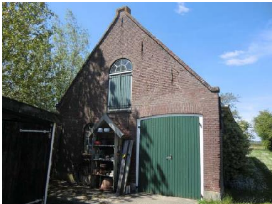
Huidige voorgevel van de wagenschuur
