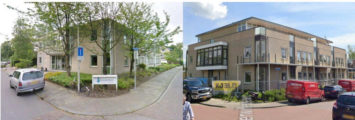
Figuur 1: Achterwillenseweg 22, Gouda (links 2014, rechts 2024). Transformatie van kantoorpand naar 12 appartementen. Start transformatie begin 2022 (Google Maps, 2024).
