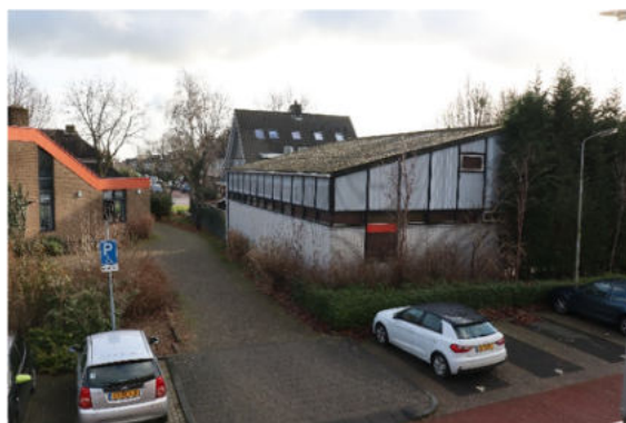
Rechts de timmerwerkplaats op nr. 8.
