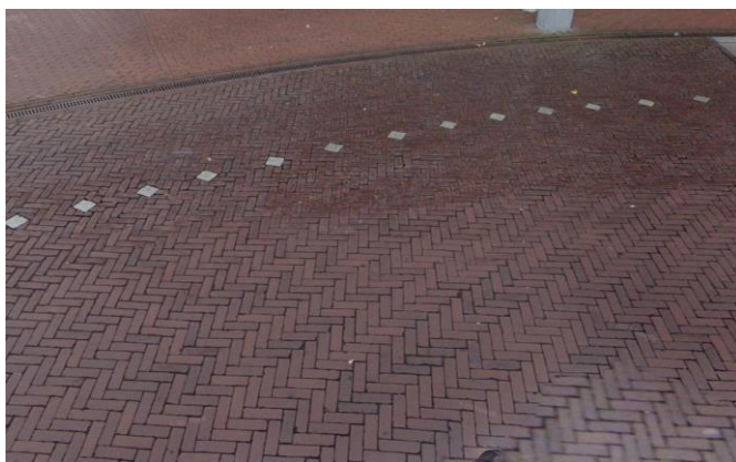
Figuur 8. Voorbeeld visuele scheiding van fietsstrook op een verharde straat met hardstenen keitjes
