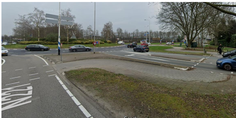
Figuur 10. Voorbeeld fietsoversteek (uit de voorrang) met slinger bij een rotonde
