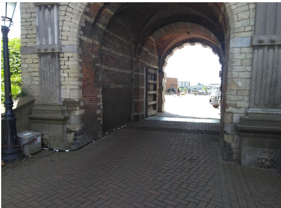
Figuur 5: geplaatste telslangen in de Veerpoort
